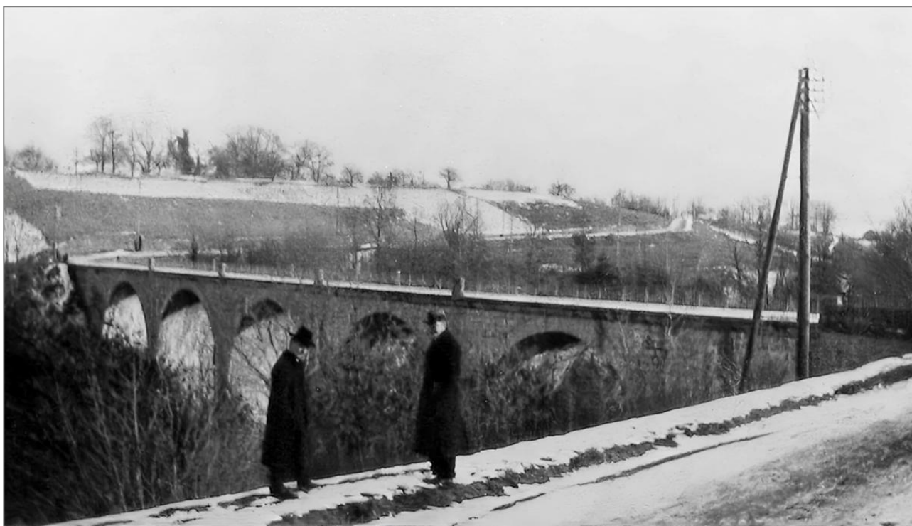
Vue du viaduc – hiver 1920
